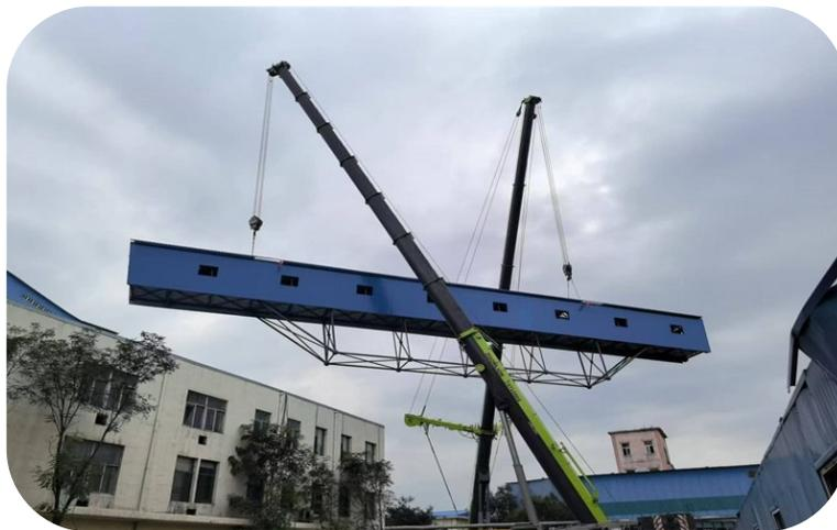
9月1日,由金信公司施工的公司重点工程镇城底选煤厂507皮带走廊经过两天的紧张施工,安全高效完成新旧桁架的拆除吊装任务。
