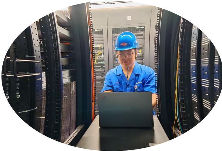
为增强处置网络与信息安全事故的能力,确保基础信息通信网络、信息系统安全稳定运行。近期,太原选煤厂电气公司职工在数据中心进行交换机、防火墙、服务器等设备日常维护,分别检查交换机、服务器等的通讯、配置和端口是否正常,供电系统是否正常。对光纤跳线、成品网线进行整理,检查标签标示是否清晰,对有折损、不可靠的跳纤、网线及时进行更换,确保信号状态正常。
